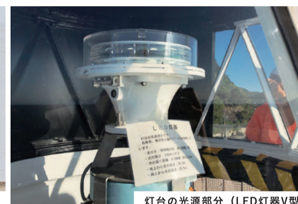
灯台の光源部分 (LED灯器V型)
